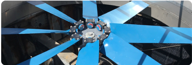
After: FRP energy-saving fan blades
