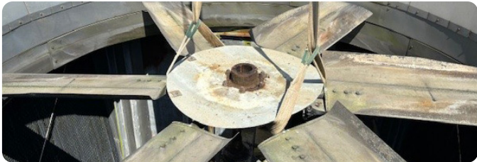
Before : Aluminum alloy fan blades
